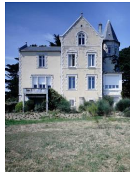
La Villa Charpentier La Garantonne
